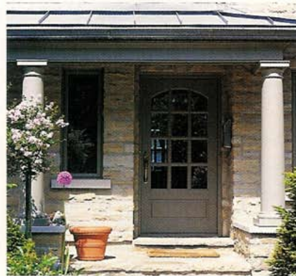
▲ Un petit toit en cuivre étamé, soutenu par des colonnes d'ordre toscan, ajoute une touche classique sans nuire à la chaleur de l'accueil.
