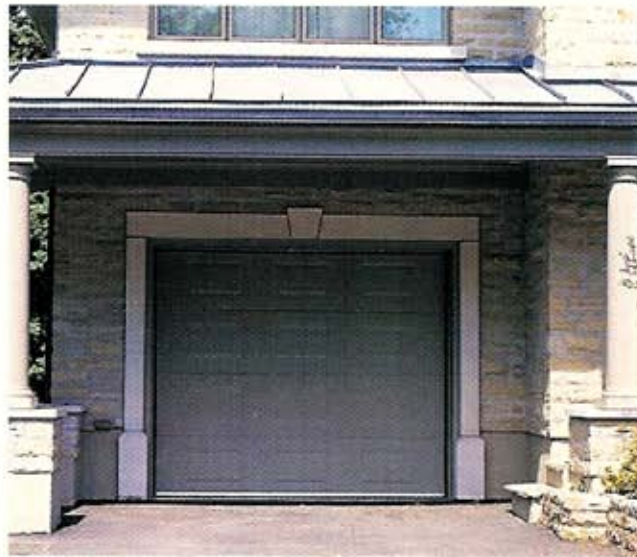
▲ La porte de garage, joliment encadrée par un chambranle en calcaire, est discrètement reléguée dans l'ombre par le portique ajouté sur la façade.
